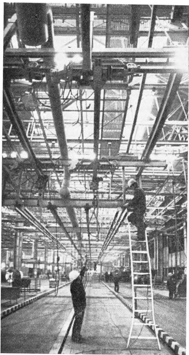
Рис. 4. Монтаж главного конвейера автосборочного завода
